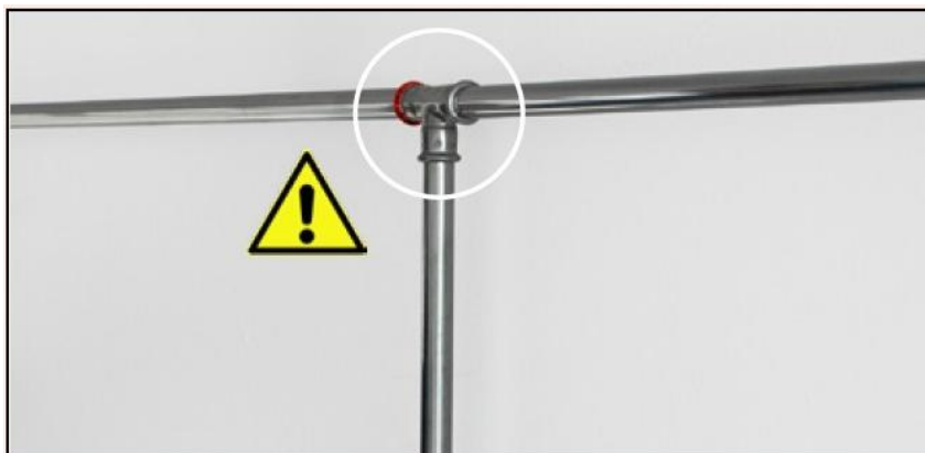
Рис. 3. Індикатор обтиску залишений на фітингу.
